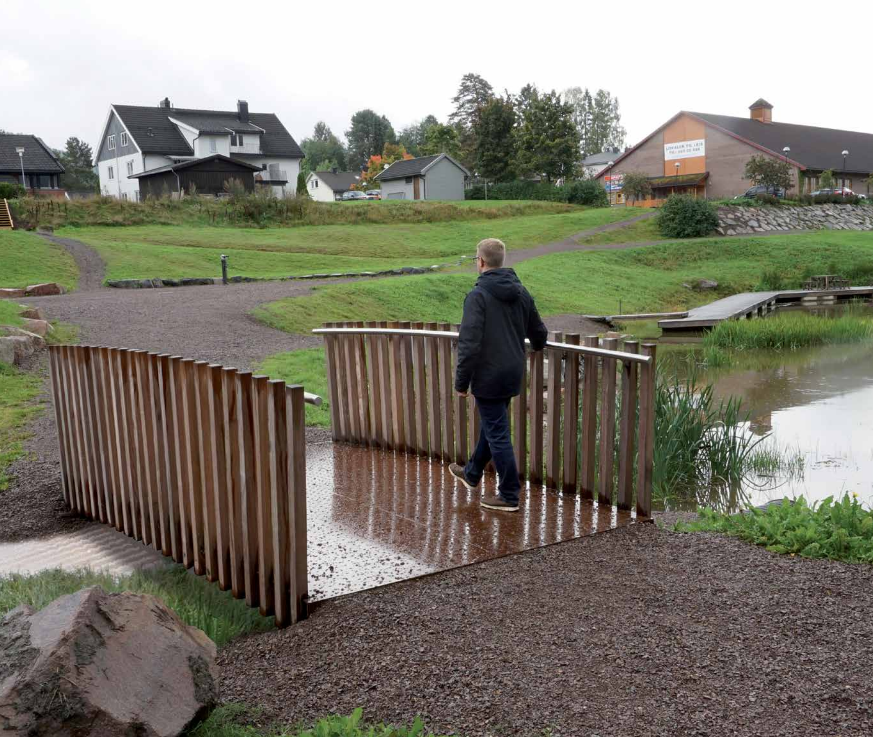
Diese Solo Brücke mit Cordeck® und Holzbalustrade im norwegischen Hvittingfoss ist 2,5 Meter breit und 4 Meter lang. Die Noppen des CorTen-Decks sorgen für eine sichere, rutschfeste Auflage.
