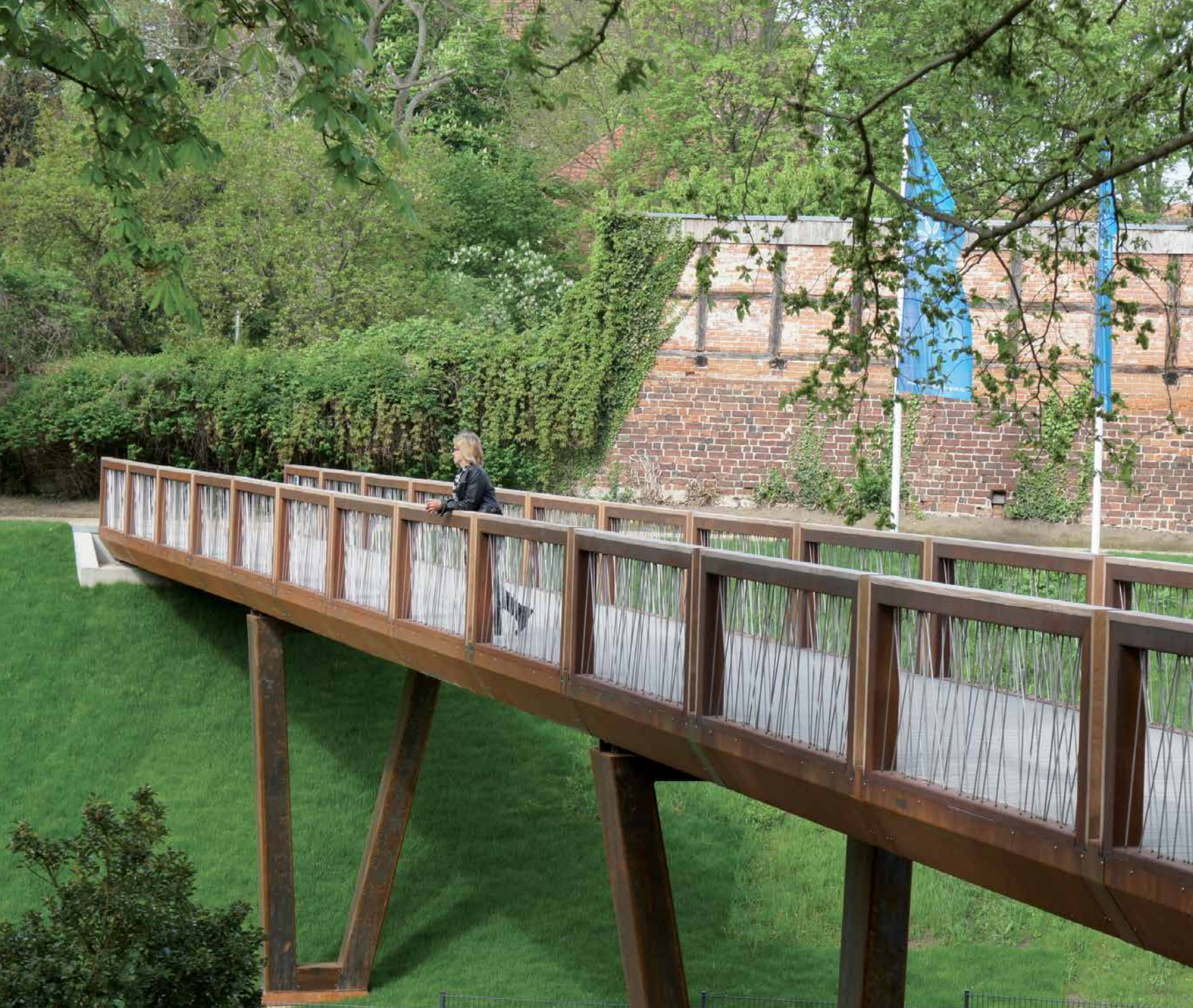
Die Organisatoren entschieden sich für die Crossline Brücke mit unregelmäßig angeordneten Edelstahlstäben als Fußgängerbrücke über die Flechte-Talsenke.
