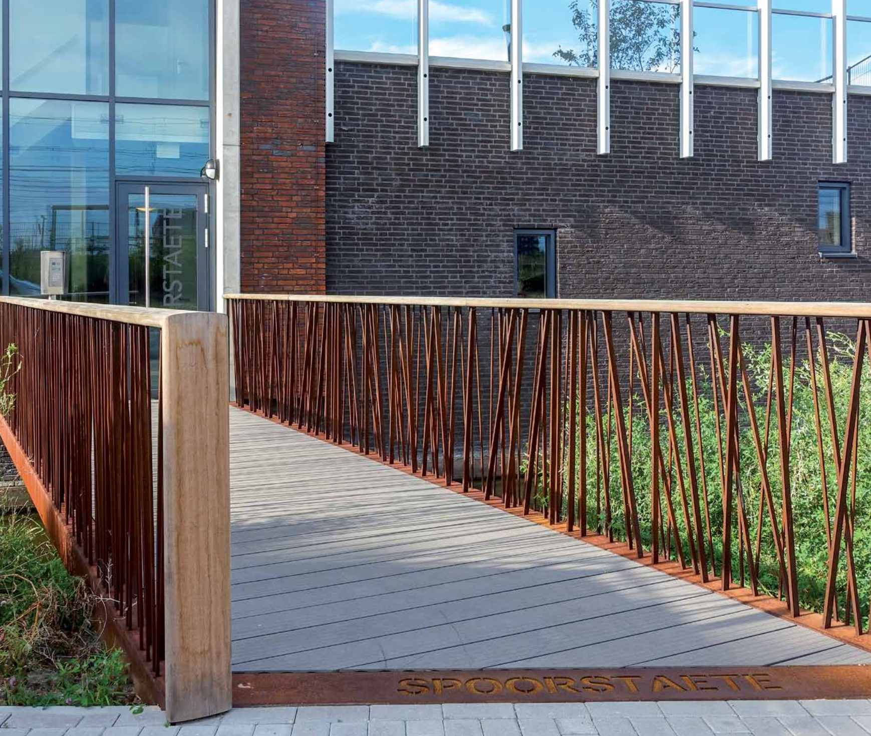
In Woerden (NL) wurde eine flache Bowie-Brücke als Zugang zum Apartmentblock Spoorstaete errichtet. Der warme Farbton des CorTen-Stahls passt optimal zur Farbe des Gemäuers.
