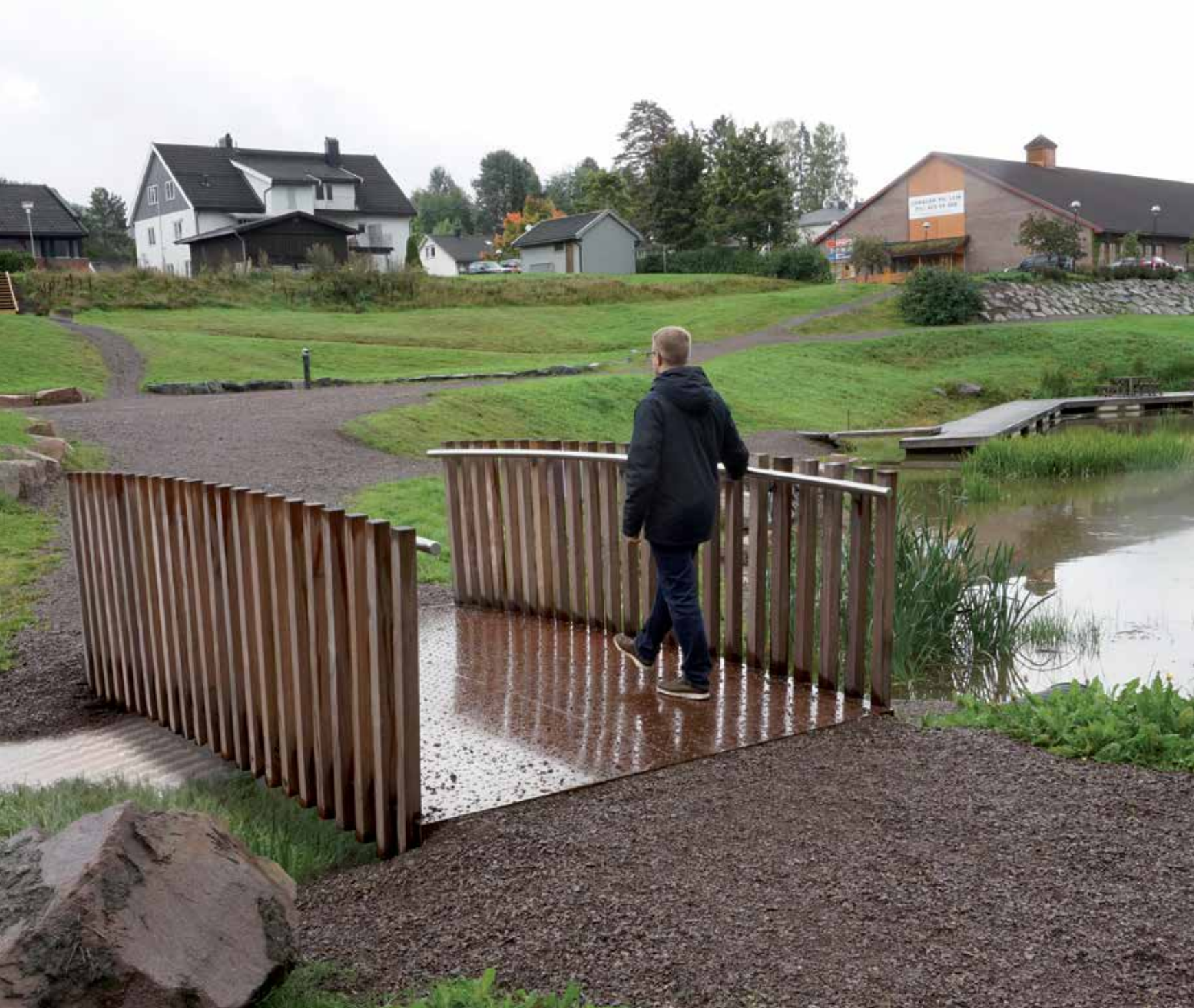
Cette passerelle Solo avec un revêtement en Cordeck© et un garde-corps en bois se trouve en Norvège, à Hvitvingfoss. Elle mesure 4 mètres de long pour une largeur de 2,5 mètres. Les aspérités confèrent au revêtement des qualités anti-glisse.
