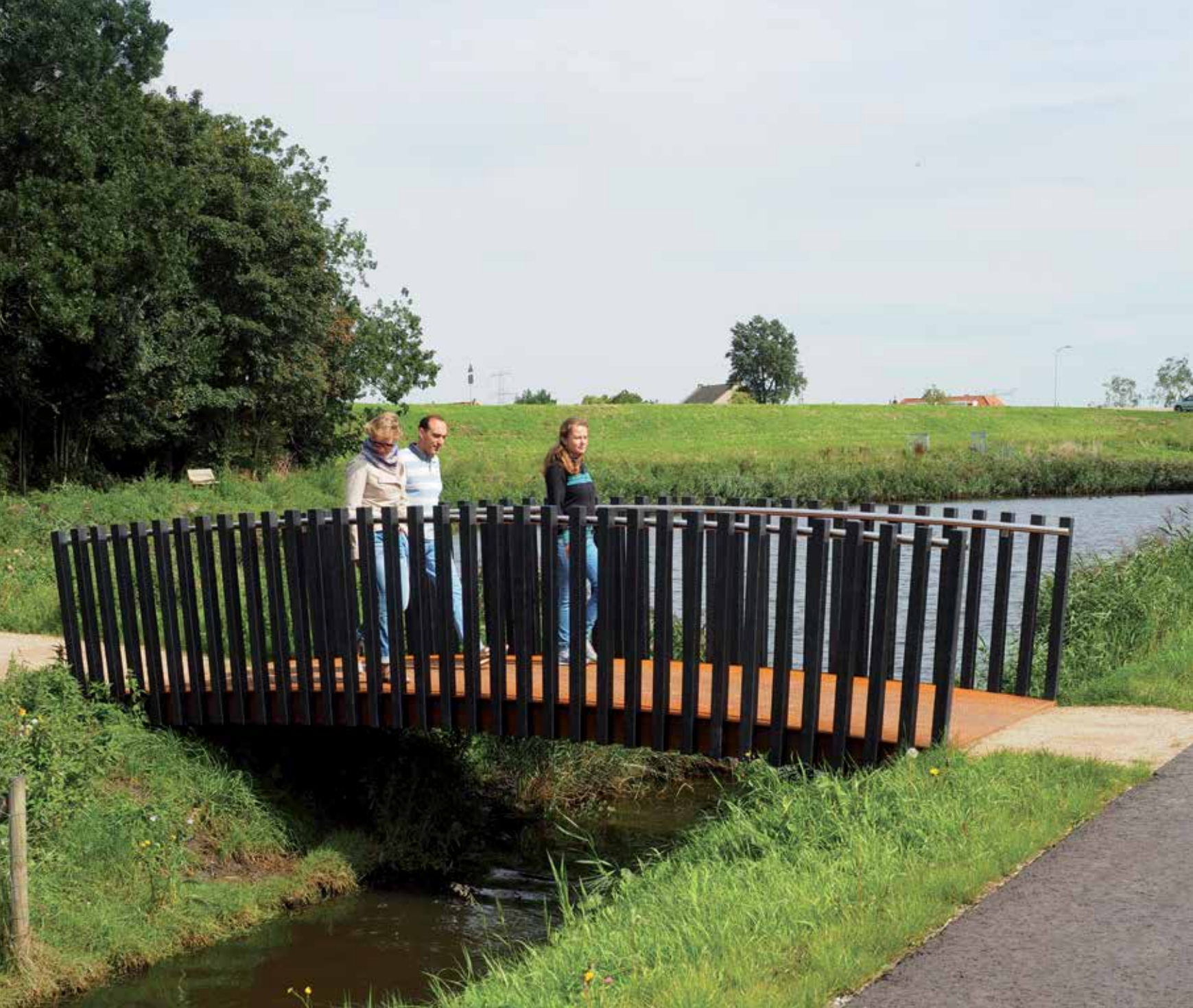
Pour cette passerelle durable toute la structure portante ainsi que le revêtement sont créés à partir d'éléments épais en acier CorTen. Les barres du garde-corps sont en matériaux All Black, et la main courante est en acier inoxydable.
