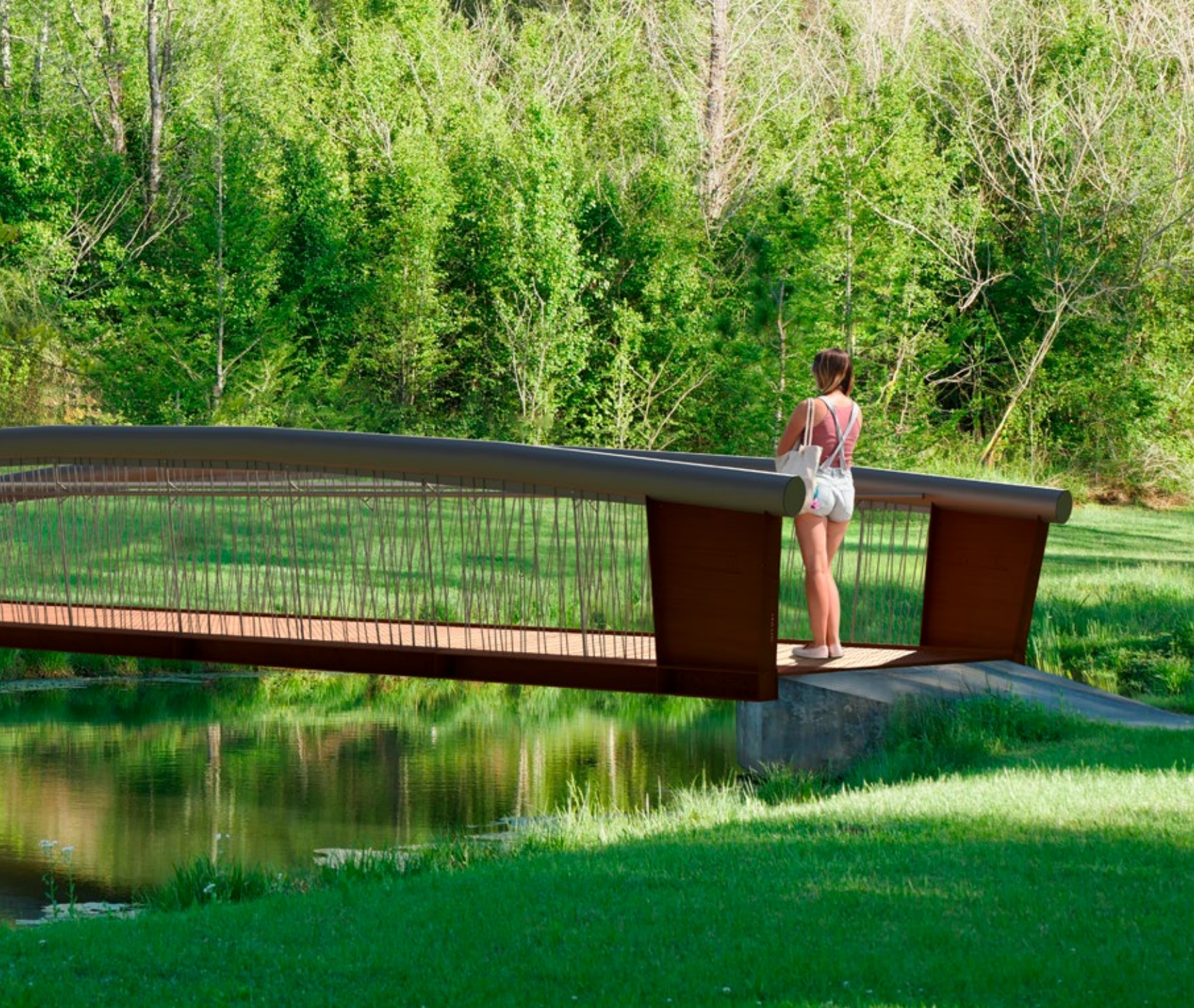
Mit kreuz und quer angeordneten Stahlstäben im 'wildem' Bowie-Muster ist das Brückendeck von einem leicht gebogenen Rohr abgehängt.
