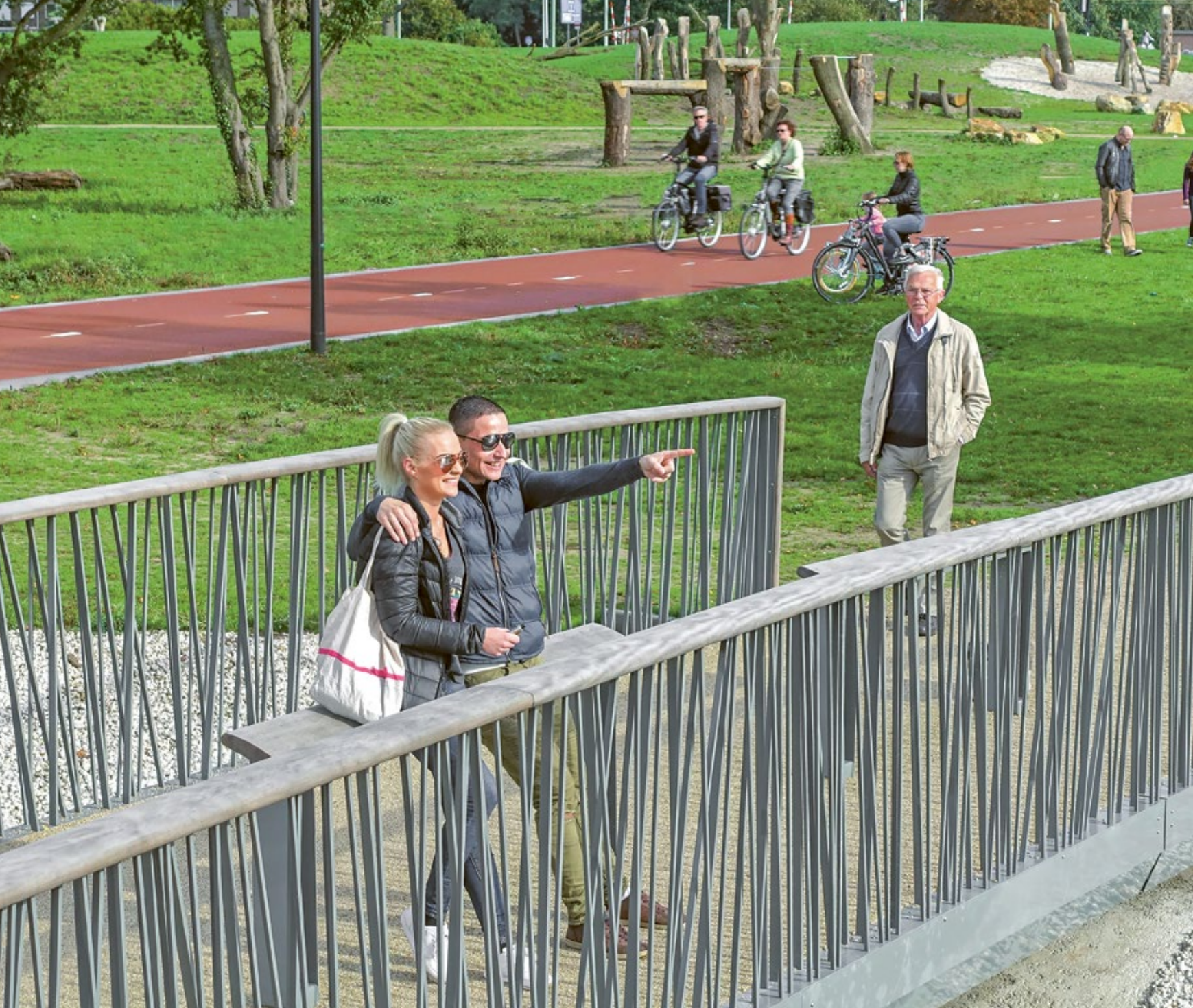
Im Watertorenpark im niederländischen Hengelo wurde diese Pulverbeschichtete Bowie-Brücke von 12 Metern Länge errichtet. Die 3 Meter breite Brücke wurde in der Mitte mit Stehhilfen ausgestattet, welche die Passanten motivieren sollen, die Aussicht auf den Park zu genießen.
